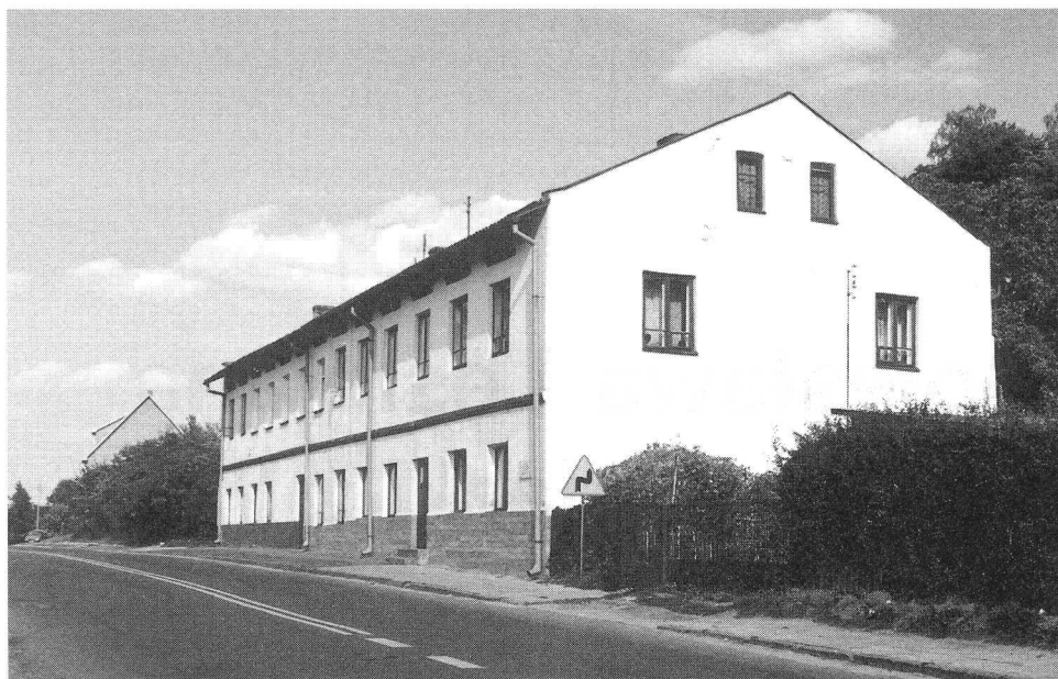
Dom Sunderlandów postawiony w miejscu dawnej fabryki fajansu przy ul. Podzamcze
