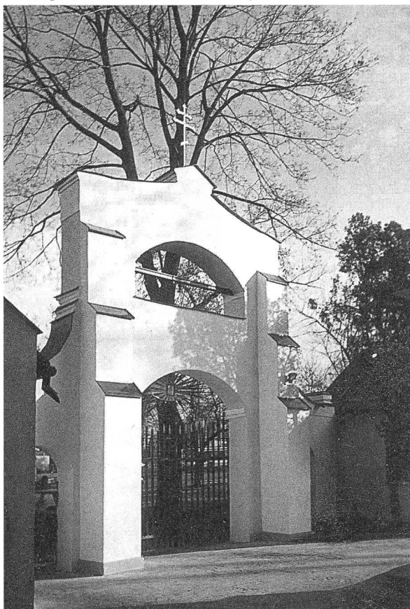
Brama po remoncie – widok od strony cmentarza
