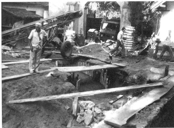
Cerkiew w trakcie budowy
