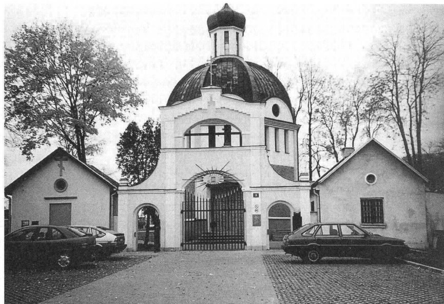
Kompleks bramy głównej po remoncie – widok od strony ulicy Warszawskiej
