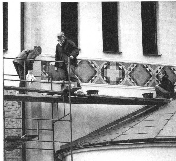
Układanie mozaiki zewnętrznej
