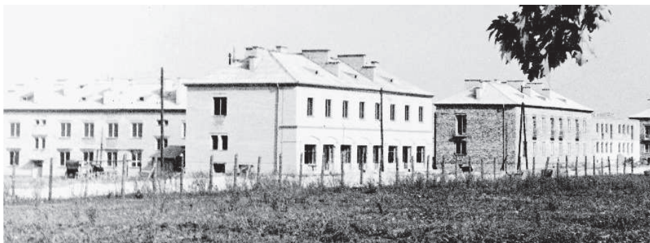
Budowa osiedla robotniczego w latach 50. i 60.
