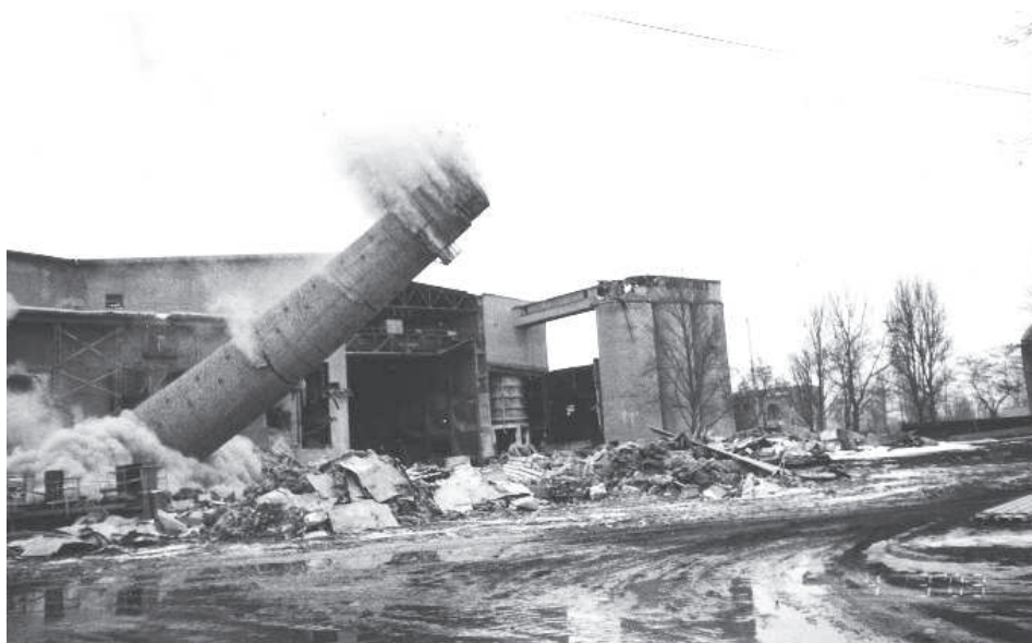
Prace przy wyburzaniu cementowni
