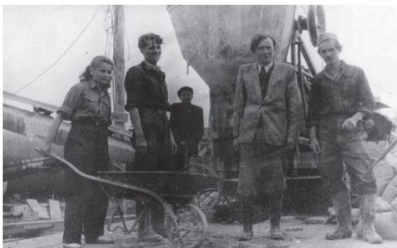
Brygada pracująca przy budowie cementowni
