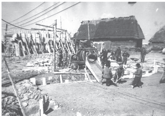
Prace przy budowie cementowni
