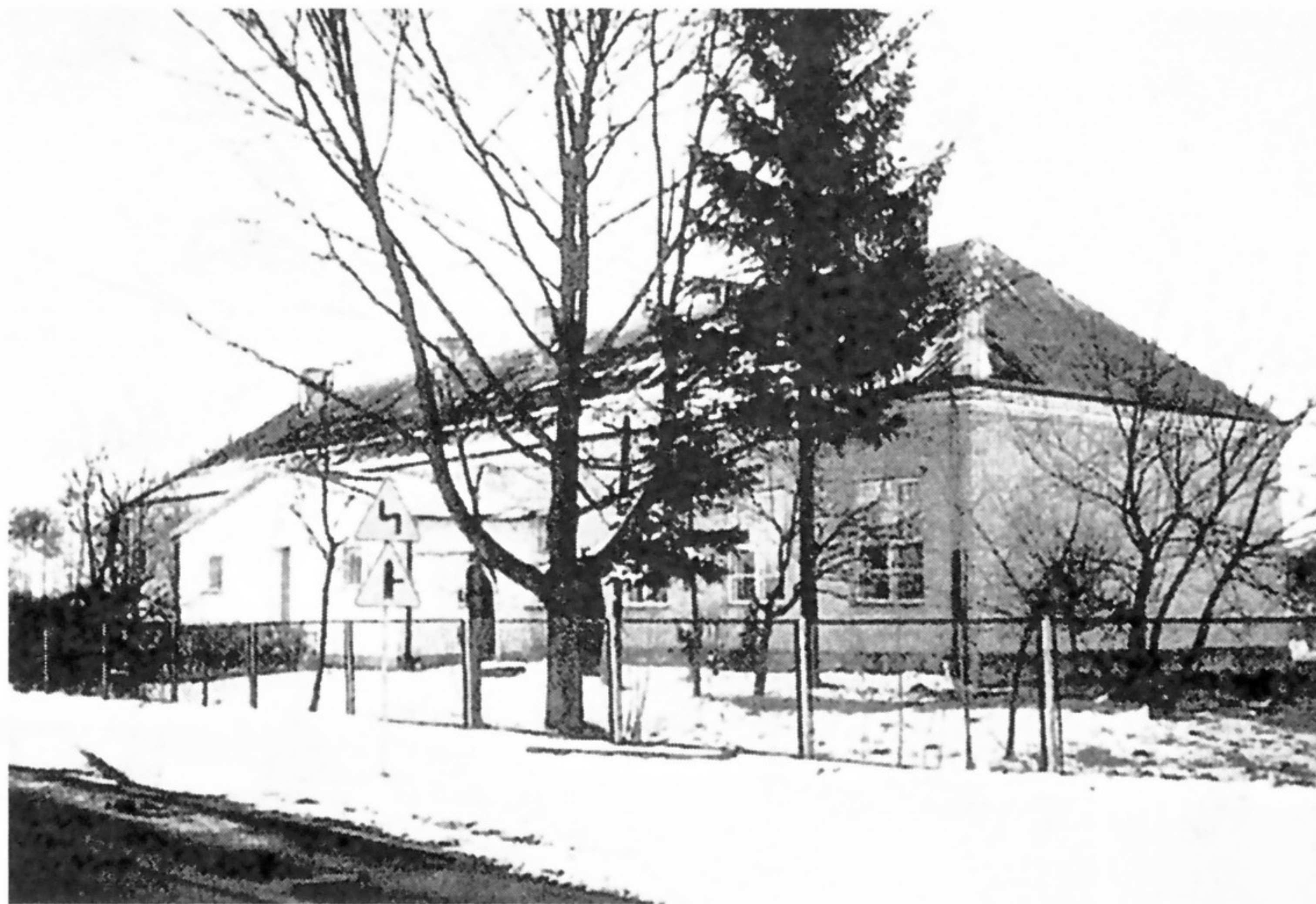
Budynek Publicznej Szkoły Podstawowej w Chechłach – stan obecny (1998)
