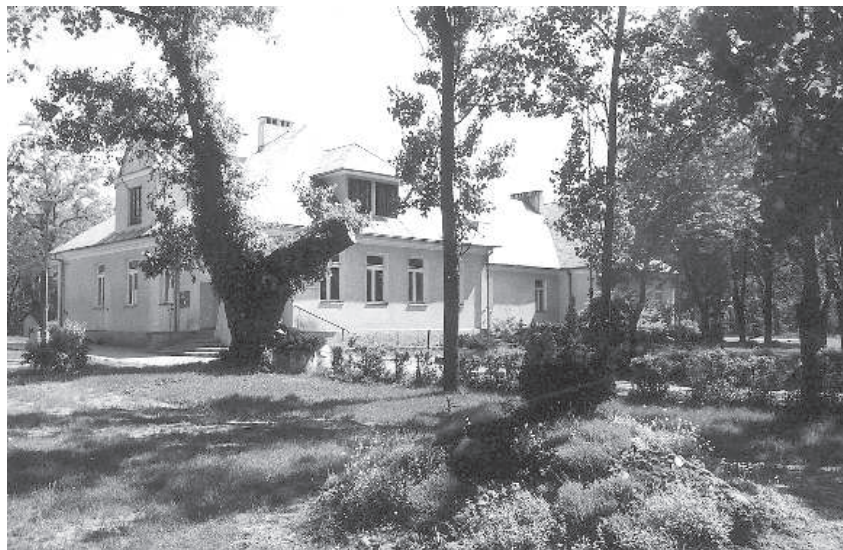
Stara część szkoły w Wysokim Kole
