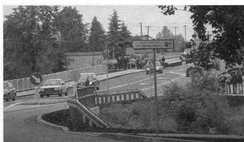
Przebudowana droga krajowa nr 79
