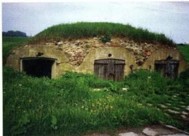
Piwnica – już nieistniejąca (fot. M. Chohuj)
