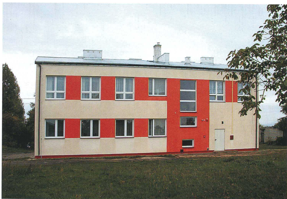
Budynek Publicznej Szkoły Podstawowej w Mszadli Starej
