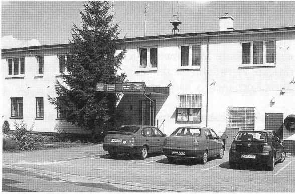
Budynek Urzędu Gminy – widok obecny
