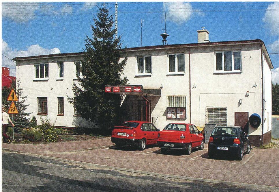
Budynek Urzędu gminy Przyłęk
