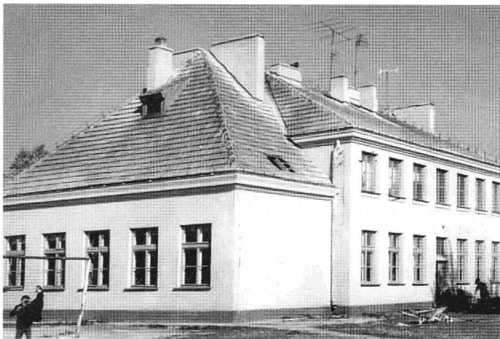
Nowy budynek szkoły w momencie oddania go do użytku (1958 r.) (fot. zbiory prywatne)
