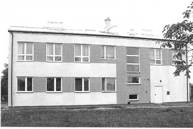
Budynek szkoły po remoncie w latach 2002–2003
