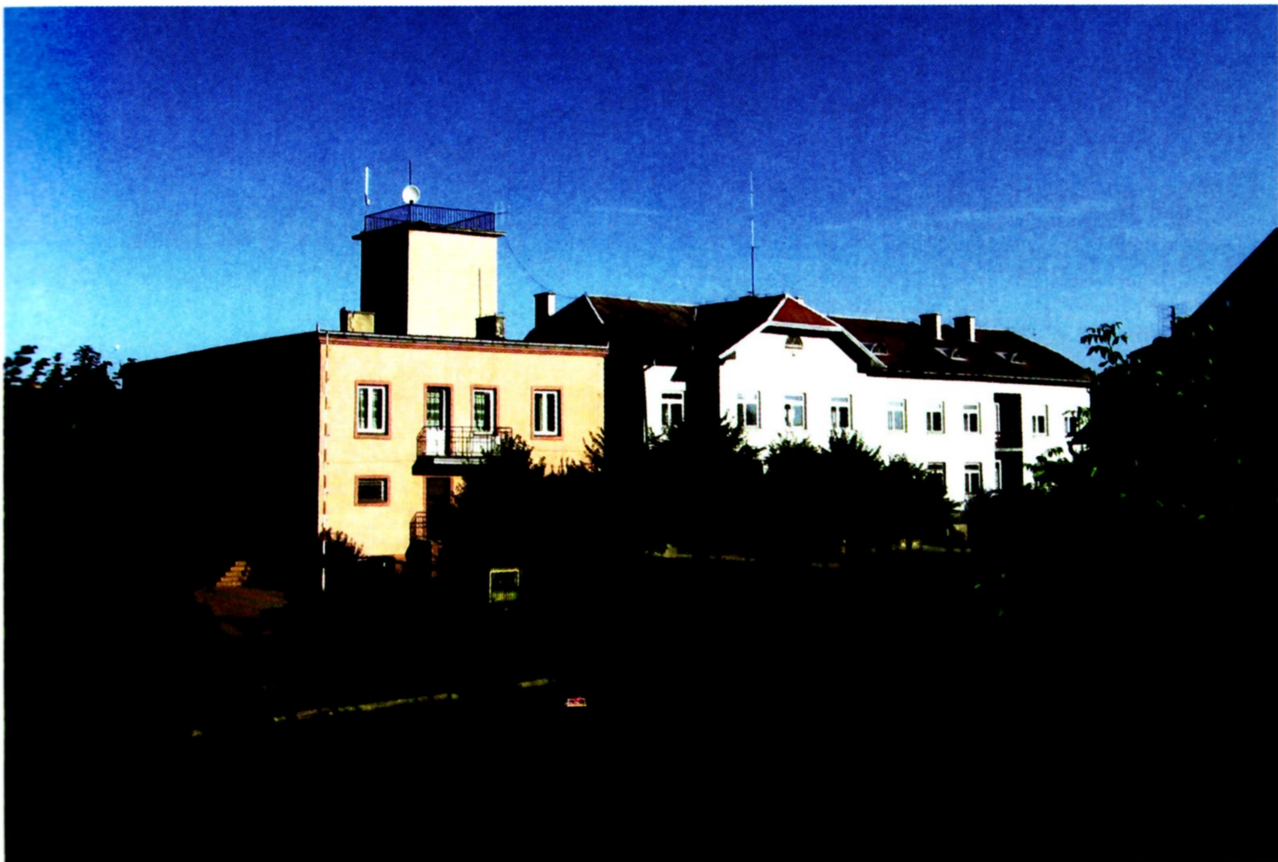
Budynek Urzędu Gminy i remiza OSP w Stromcu (fot. E. Mielniczek)
