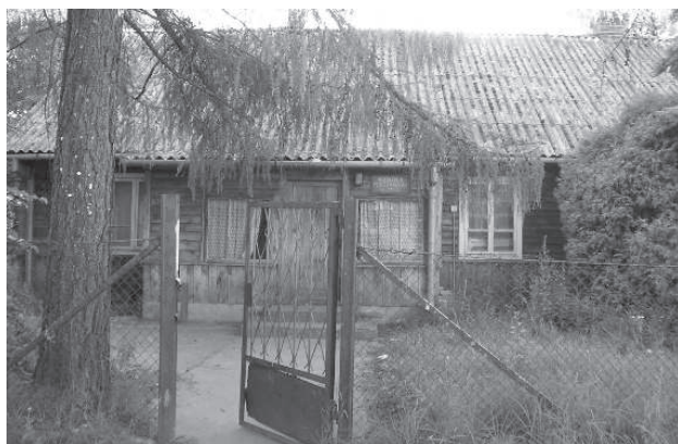
Budynek szkoły w Żydach
