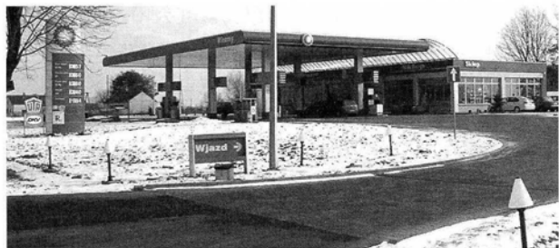
Stacja paliw w Zamościu Starym
