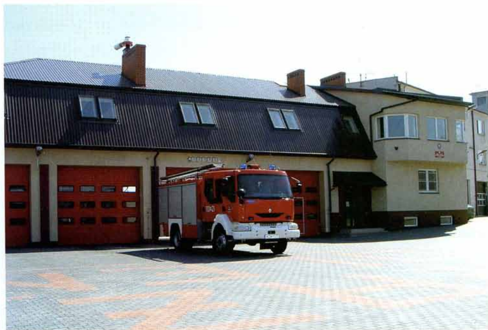
Budynek Straży Pożarnej w Zwoleniu
