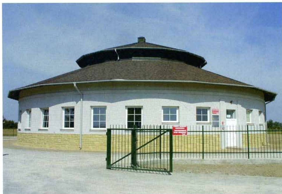
Przepompownia wody – Zwolen
