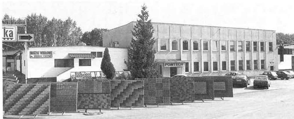
Zakład produkcji kostki brukowej – POMTECH
