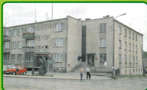
Budynek Urzędu Gminy
