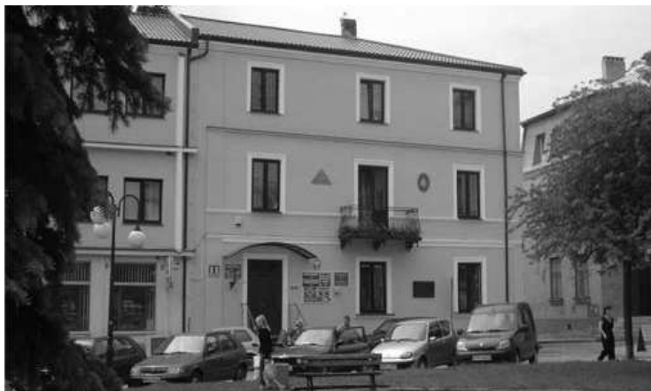
Rys. 2.3.2. Budynek Urzędu Miejskiego w Ilży
