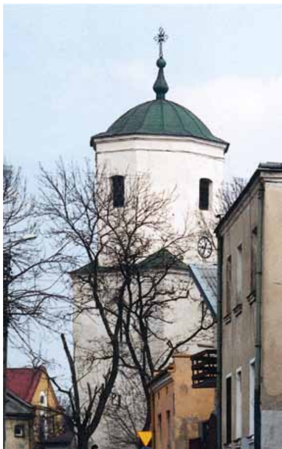
Dzwonnica przy kościele pw. Wniebowzięcia NMP The bell tower by Assumption of the Blessed Virgin Mary Church (fot. / photo: J. Madejski)
