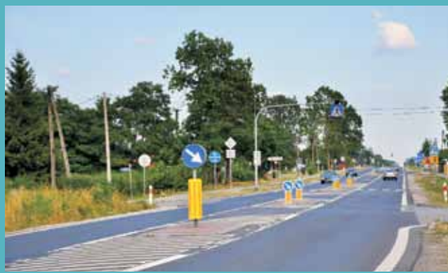
Nowa droga krajowa nr 12 National Road 12 (fot. / photo: R. Kusio)
