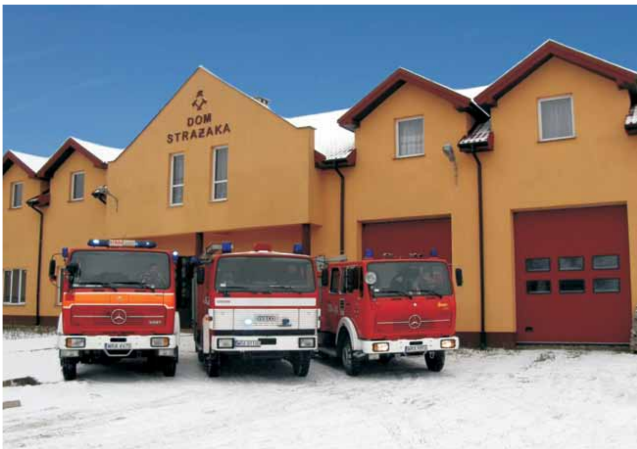
Dom Strażaka w Goździe / Firefighter Centre in Gózd (fot. / photo: archiwum gminy / from the parish's archives)
