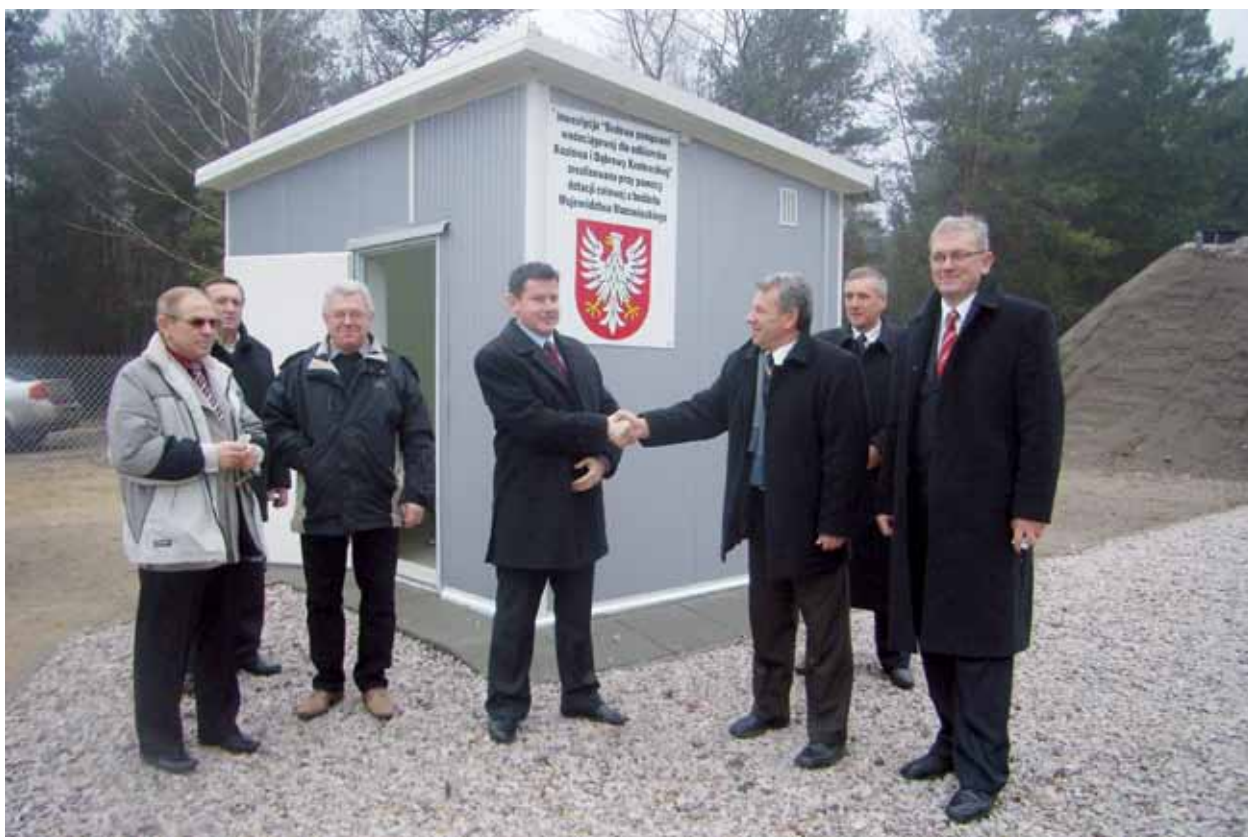
Oddanie stacji pompowej dla Kozłowa i Dąbrowy Kozłowskiej. Wójt Gminy Jastrzębia Zdzisław Karaś (trzeci z prawej) przyjmuje gratulacje od Piotra Szprendałowicza – członka Zarządu Województwa Mazowieckiego / The opening of the pump station for Kozłów and Dąbrowa Kozłowska. Village mayor Zdzisław Karaś (third from the right) accepting congratulations from Piotr Szprendałowicz – member of the Mazovian Voivodeship Board (fot. / photo: archiwum gminy / from the parish's archives)
