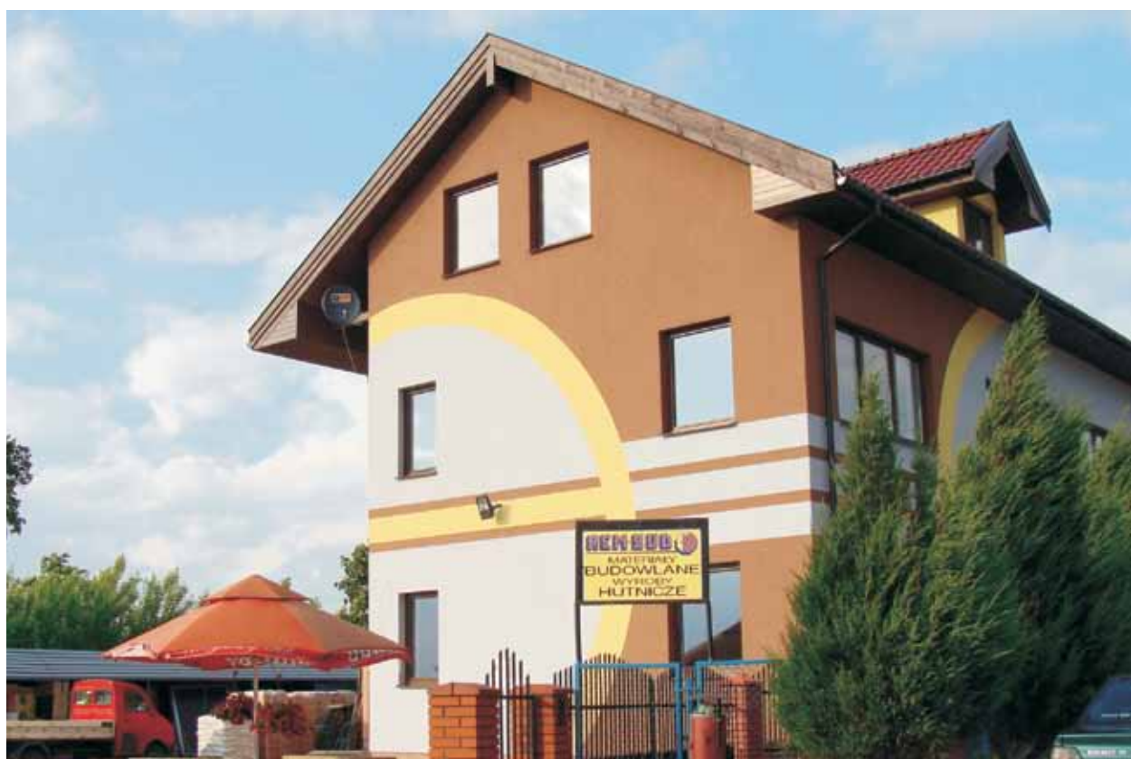
Budynek Przedsiębiorstwa REM-BUD / The building of REM-BUD enterprise (fot. / photo: E. Nowakowska)
