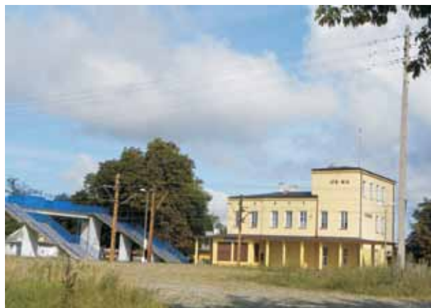
Dworzec PKP w Jedlni-Letnisku Railway station in Jedlnia-Letnisko (fot. / photo: K. Orzeł)
