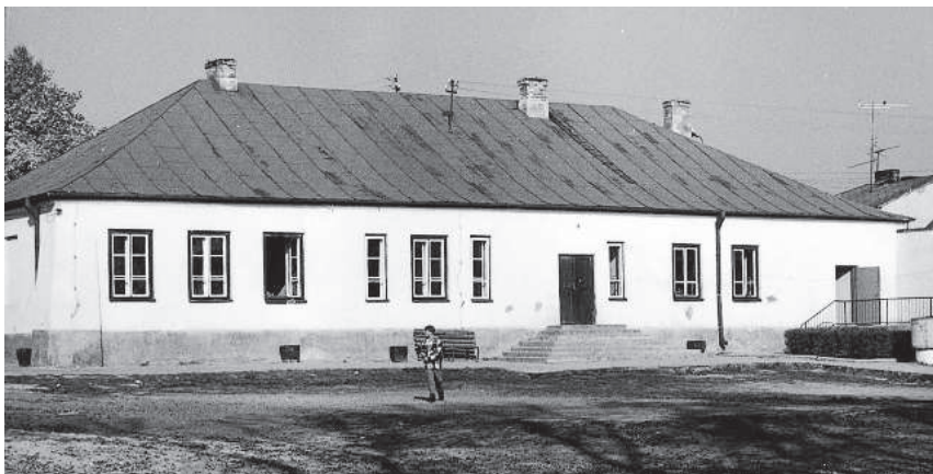
Budynek Publicznego Gimnazjum w Ciepeliowie
