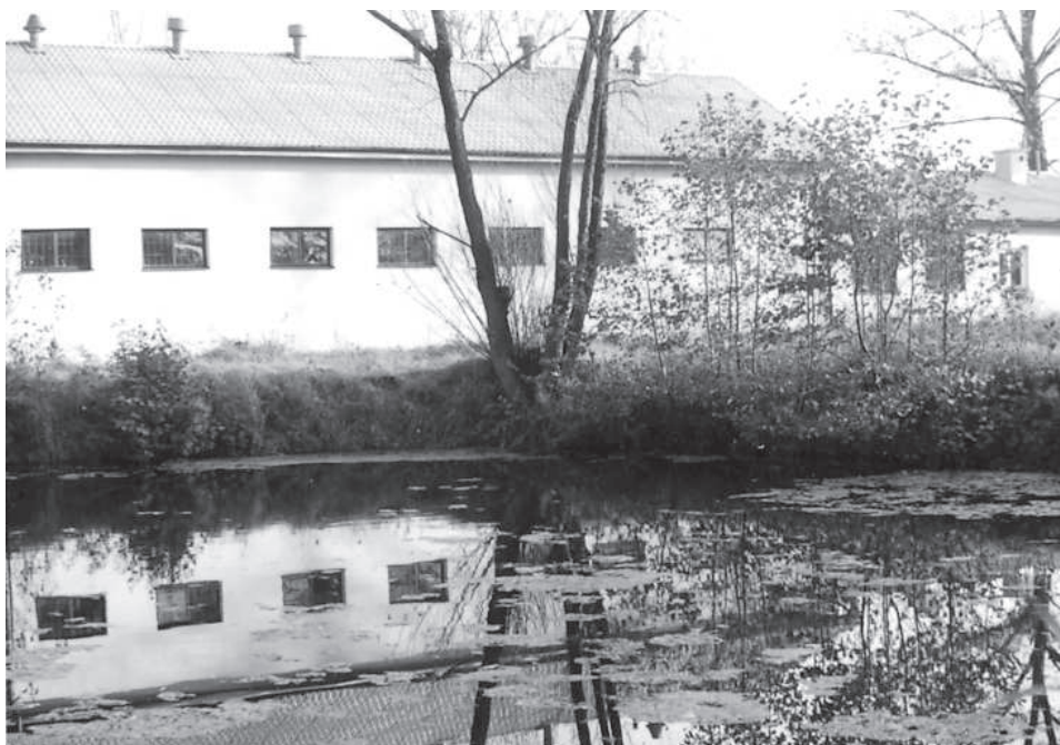
Oczyszczalnia ścieków (fot. B. Czaplą)
